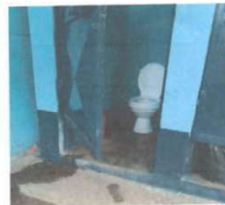
FOTO 6: REPARACIÓN O SUSTITUCIÓN DE AZULEJO Sustitución de piso Tipo: azulejo, trabajo de nivelación, instalación alineada y sizado en juntas.
