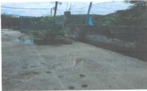
FOTO 1: PINTURA EN MUROS INTERIOR Y EXTERIOR Preparación de la superficie y aplicación de pintura, en paredes interiores y exteriores del establecimiento y retoque de logo
