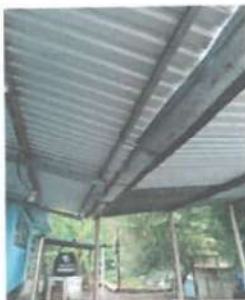
FOTO 5: CANALES Y BAJADAS DE AGUA PLUVIAL Sustitución de canales para evacuación de aguas pluviales Material: lamina galvanizada Tipo: lisa, Anclaje: canal sostenido por pescantes metalicos
