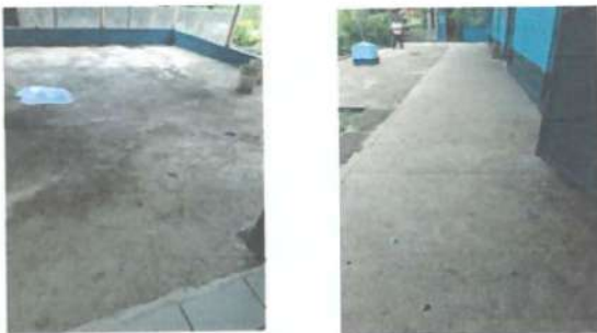
FOTO 3: PISO Sustitución de piso de concreto con acabado liso por piso cerámicos antideslizante, incluyendo preparación de superficie y nivelación.
